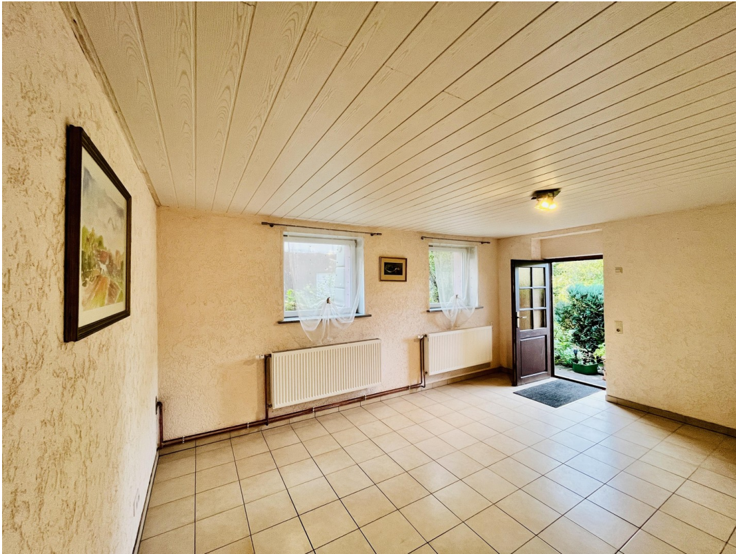
UG Raum 1 (ausgebaut)
