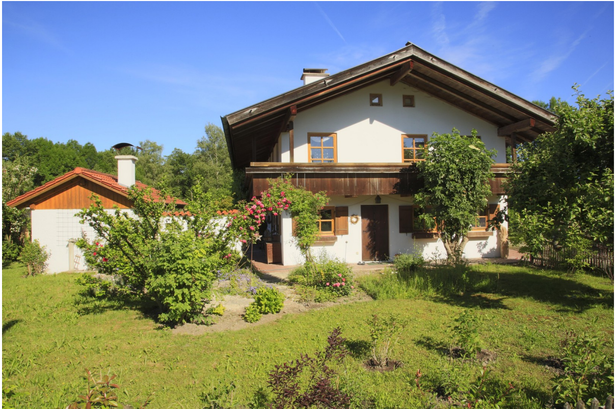
Alte Strassenansicht ohne Bepf
