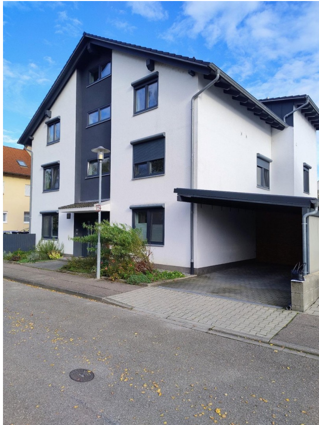
Außenansicht mit Carport
