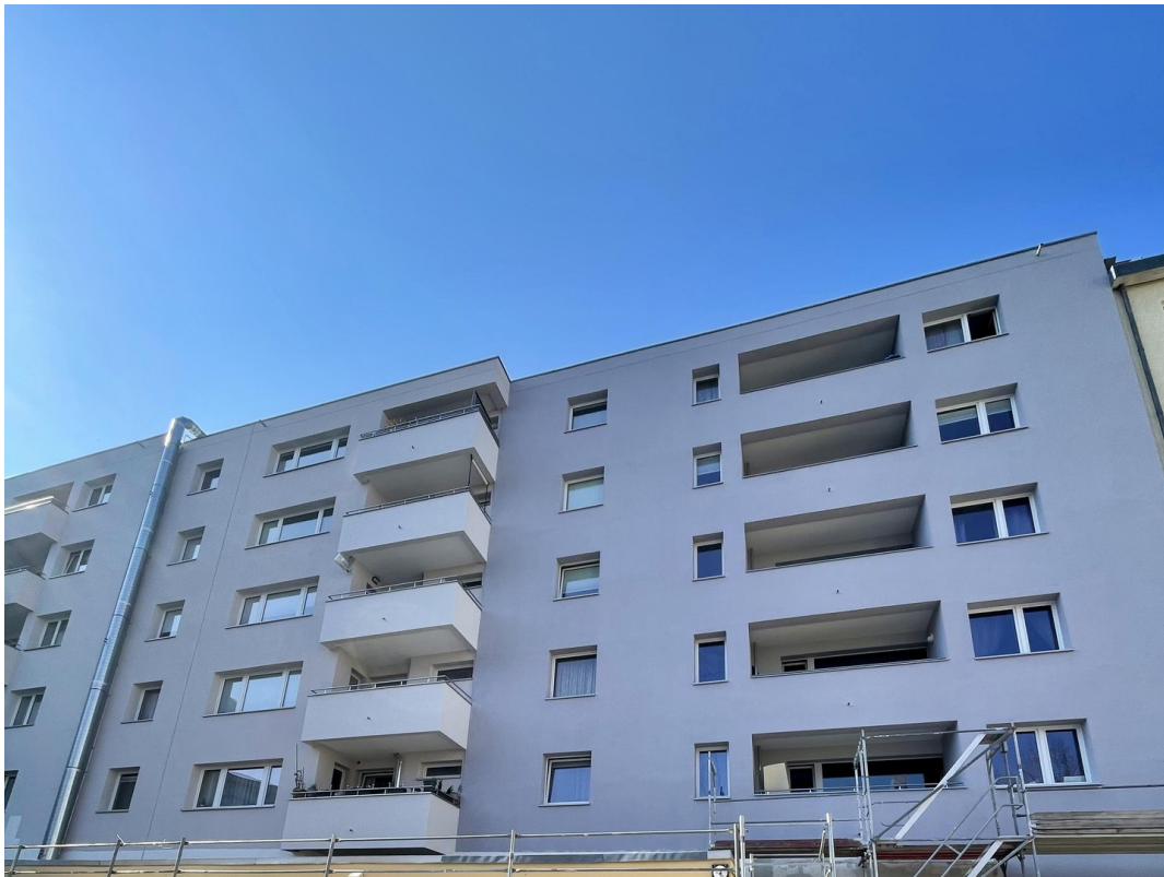
Hausansicht nach Sanierung
