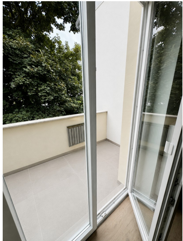
Austritt zum Südbalkon
