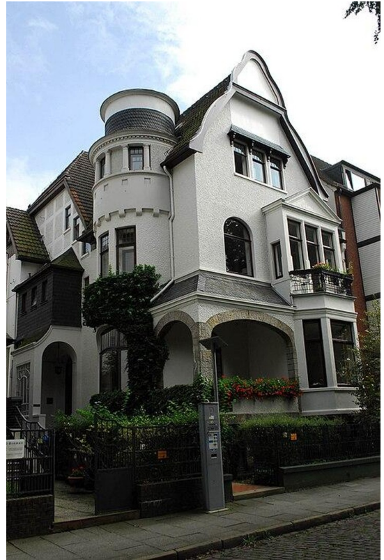
Frontseite des Hauses
