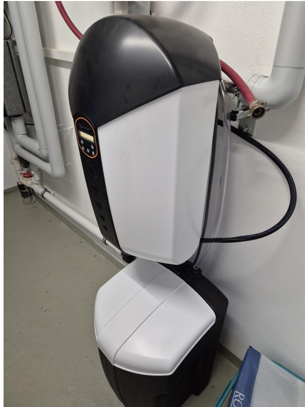
Entkalkungsanlage
