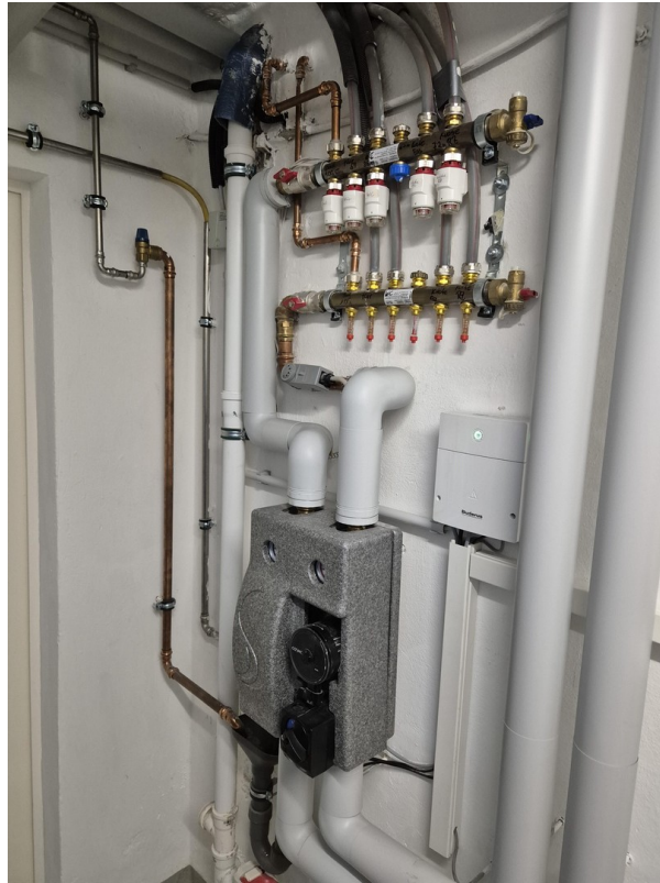
Verteilung Fußbodenheizung
