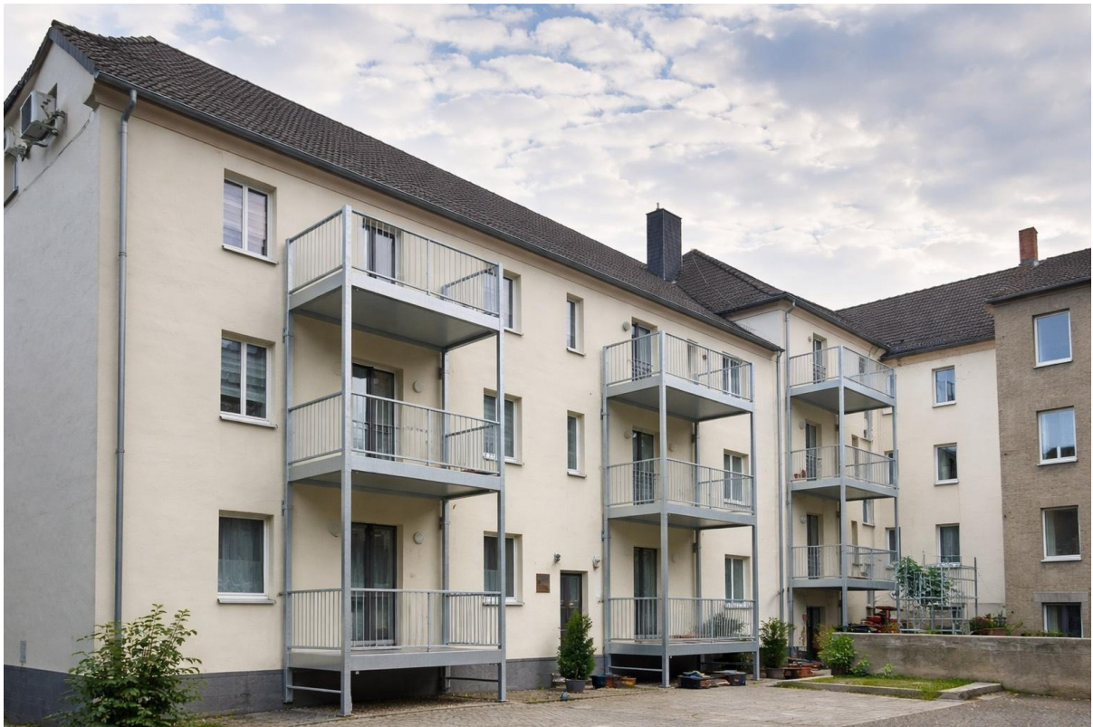
Balkone und Fassade
