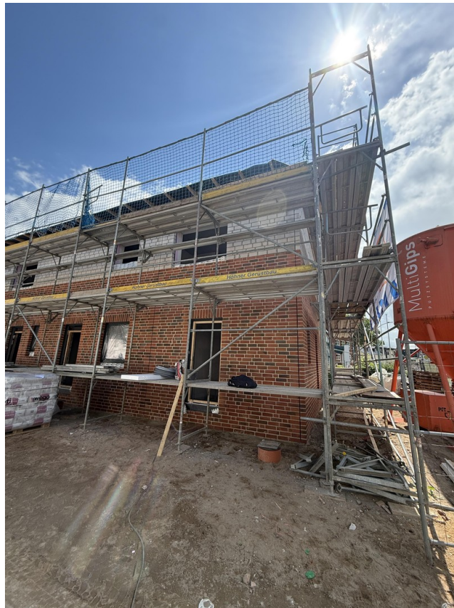
Aktuell im Bau
