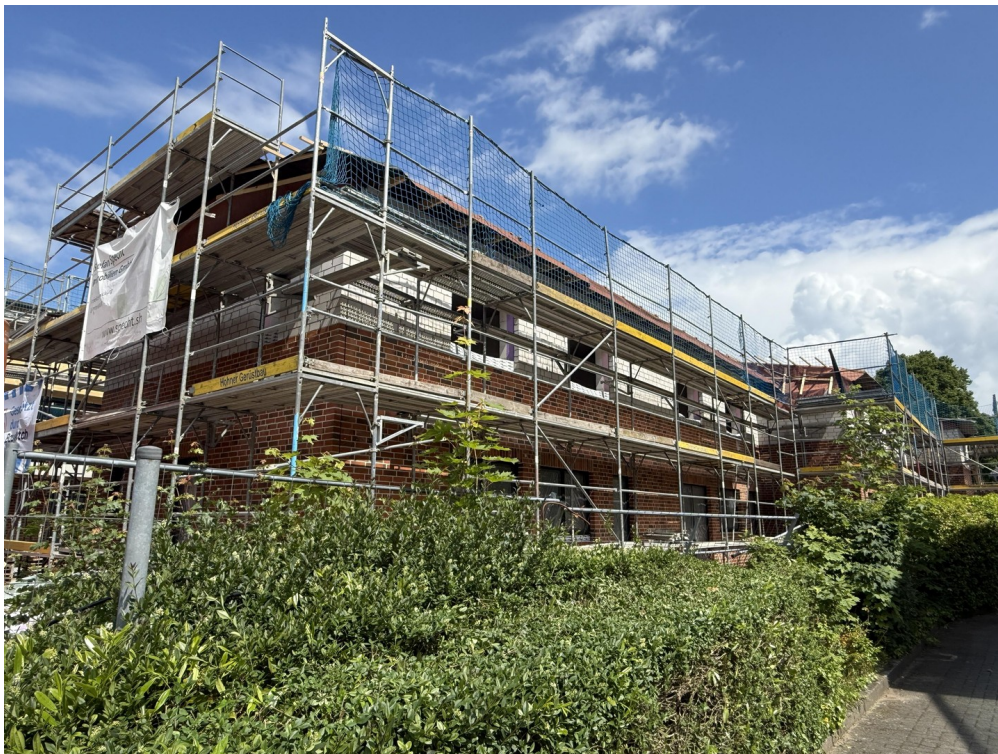
Aktuell im Bau
