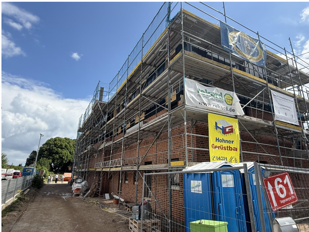
Aktuell im Bau
