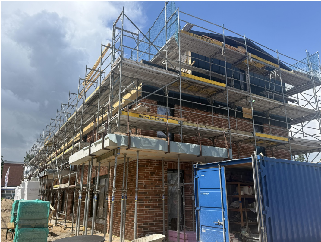
Aktuell im Bau
