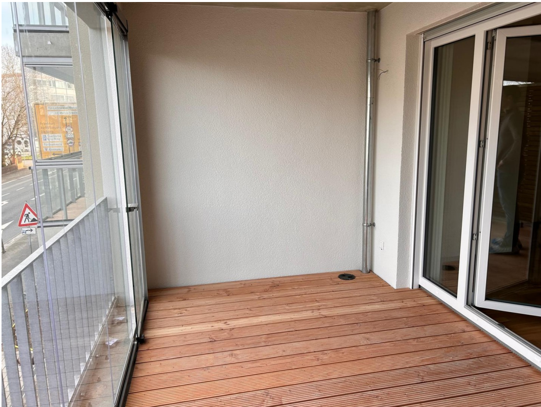
Loggia mit Lärmschutz
