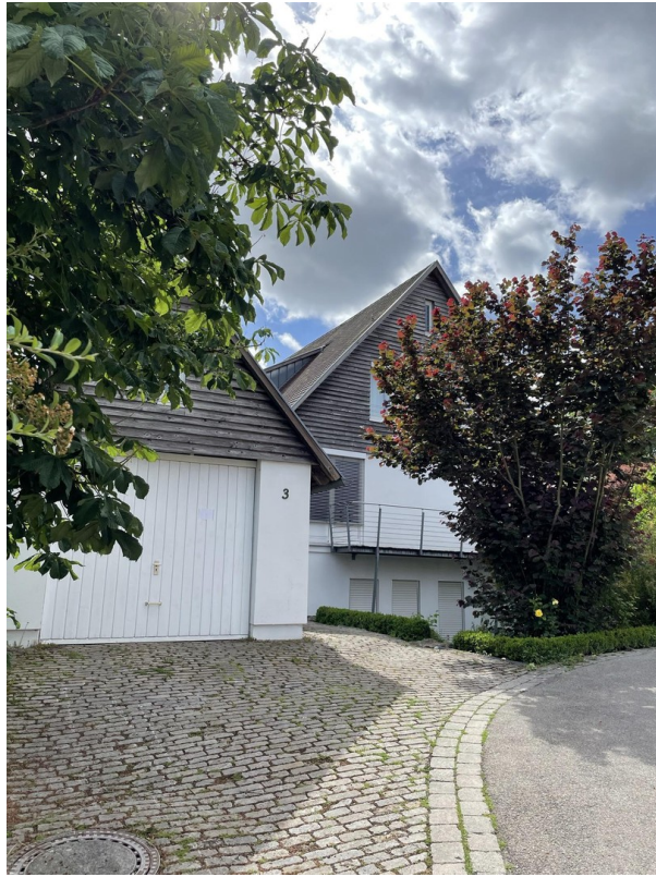
Westansicht mit Garage
