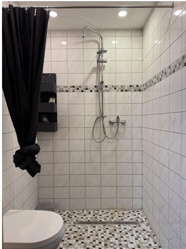
Dusche / WC Untergeschoss
