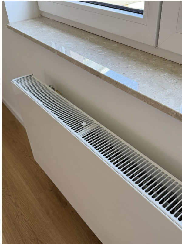
neue Heizkörper / Fensterbank
