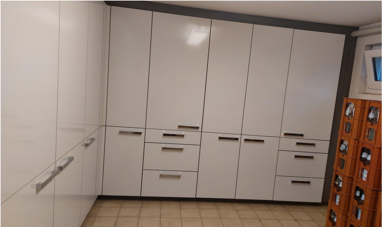
Einbauschränke im Keller
