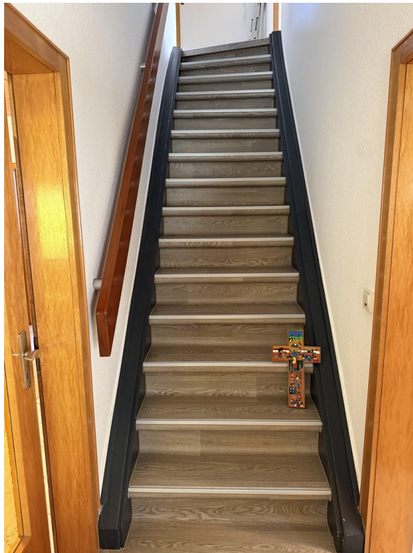
Treppe zum OG
