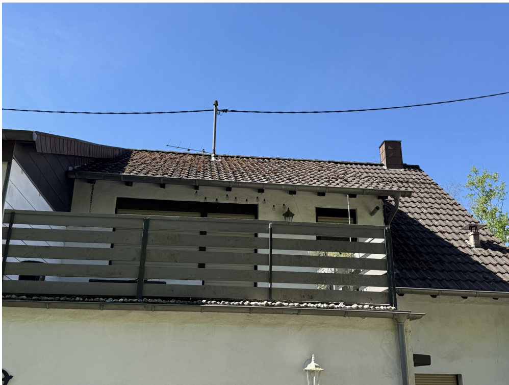
Rückseite mit Dachterrasse
