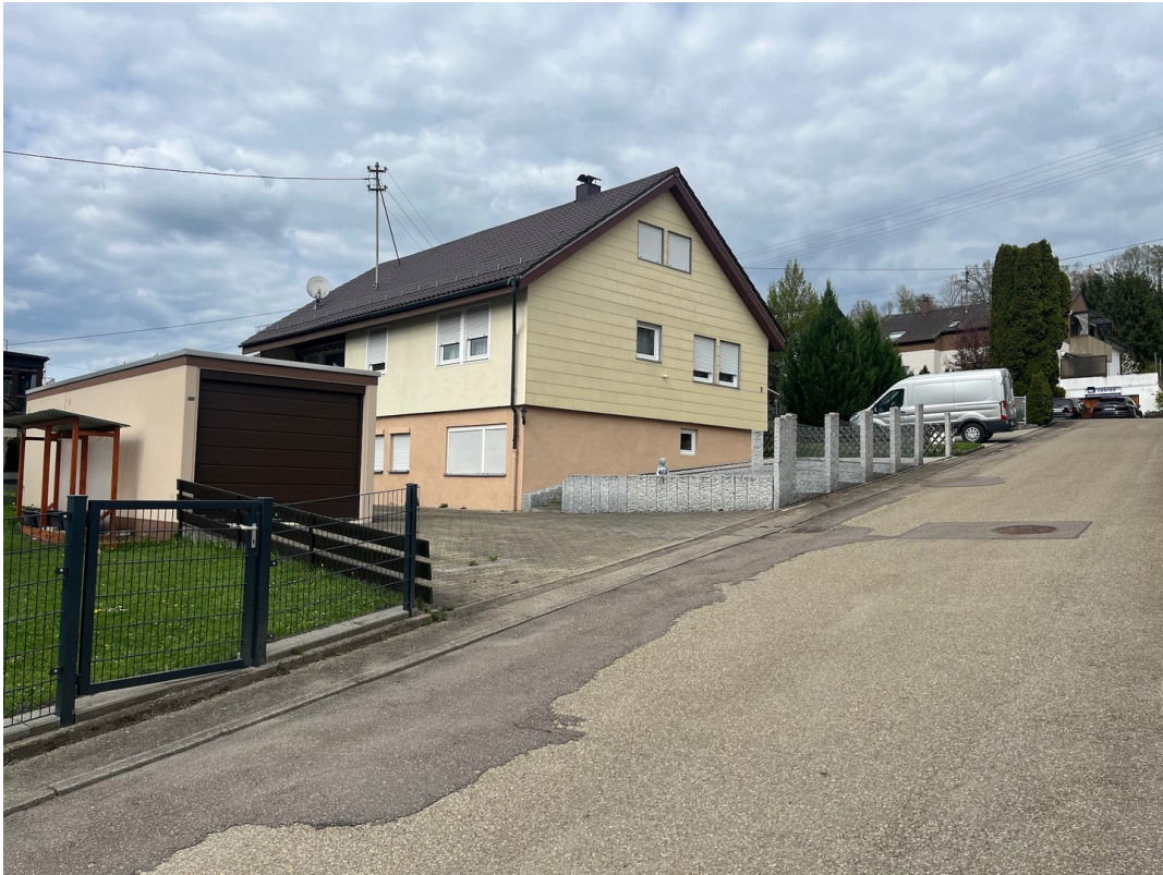
Straßenansicht von unten
