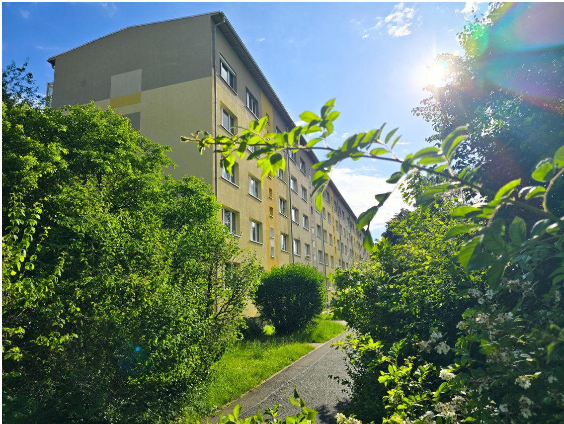
Blick von Nordost
