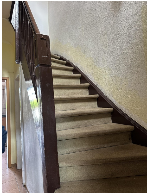
Treppe nach oben
