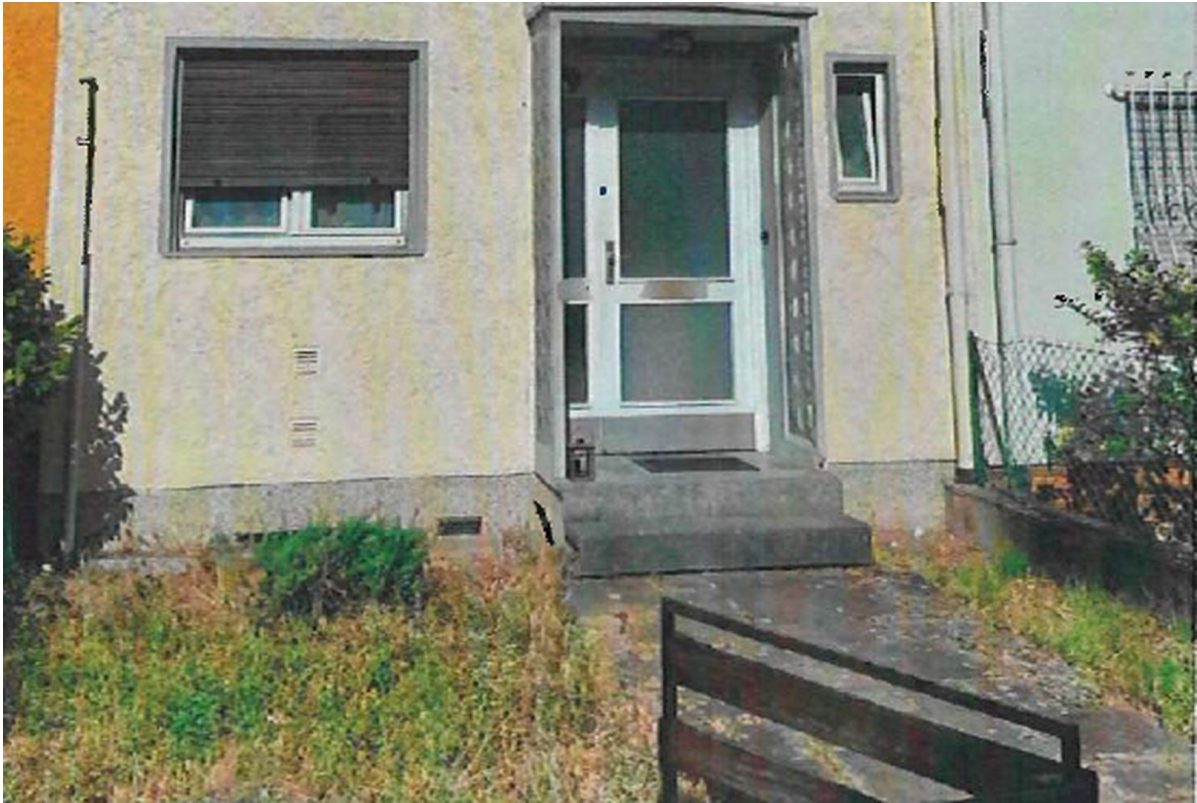
Hauseingang mit Vorgarten
