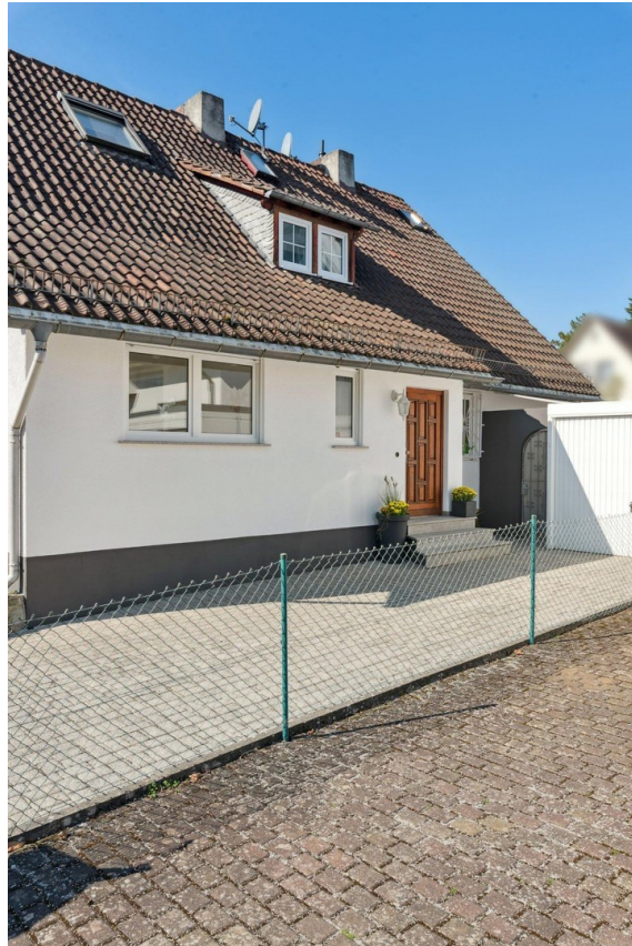
Hauseingang, Einfahrt, Garage
