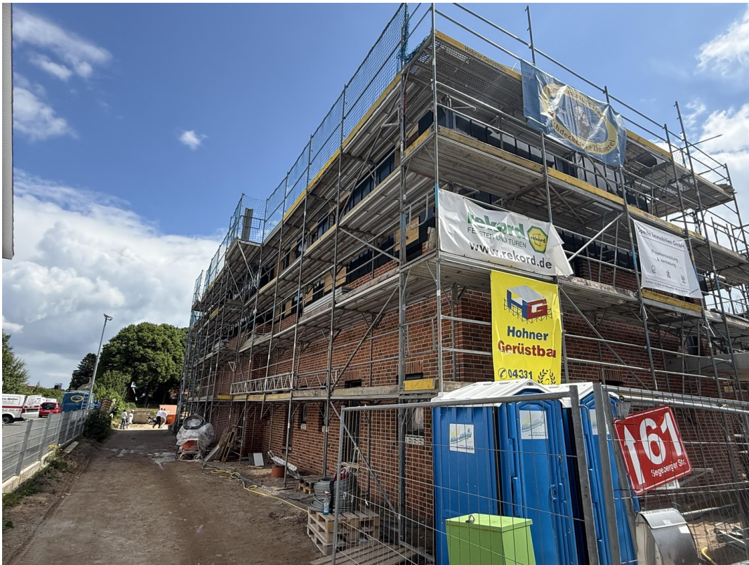
aktuell im Bau
