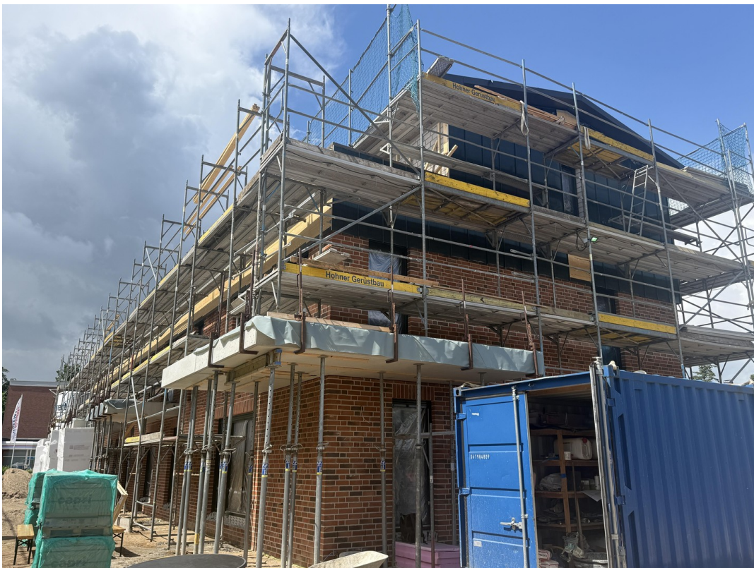
aktuell im Bau
