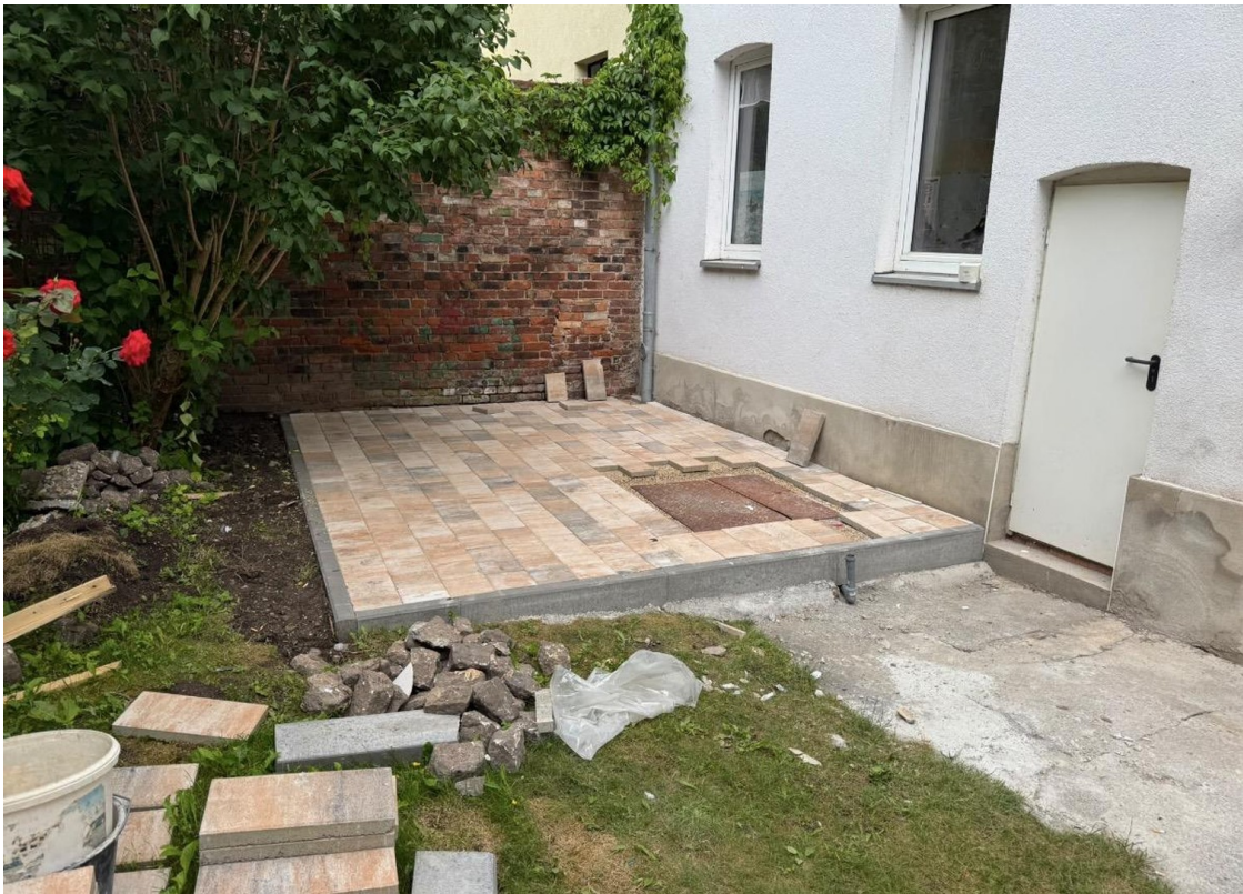
Terasse - Balkontür kommt noch
