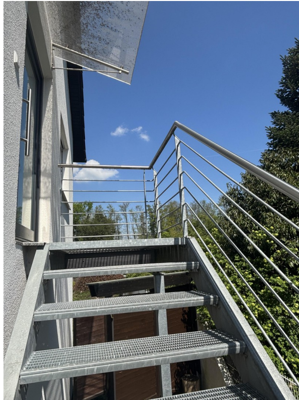
OG Treppe zur Haustür
