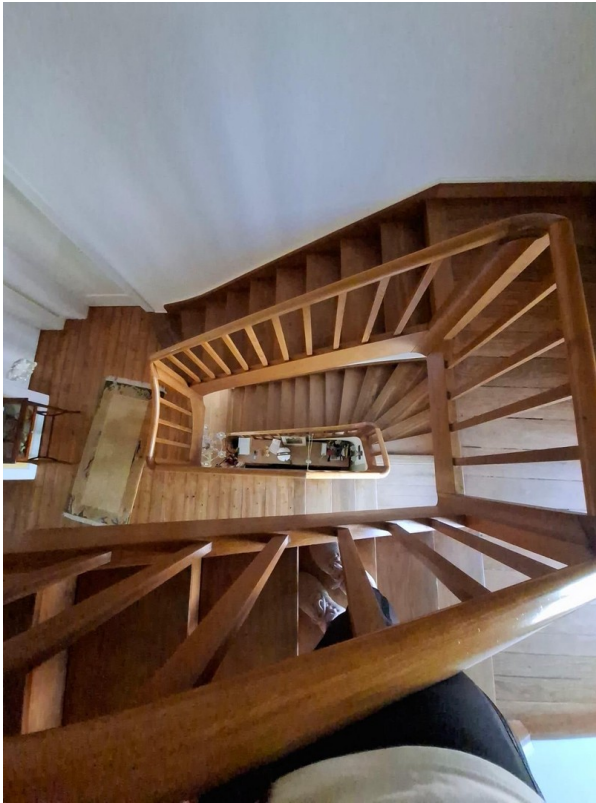
Treppenhaus von oben
