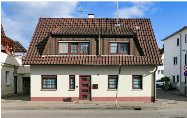
AUSSENANSICHT WEST-SEITE · 200m 2 Grundstücksfläche · ca. 140m 2 Wohnfläche · zugehörige Scheune
