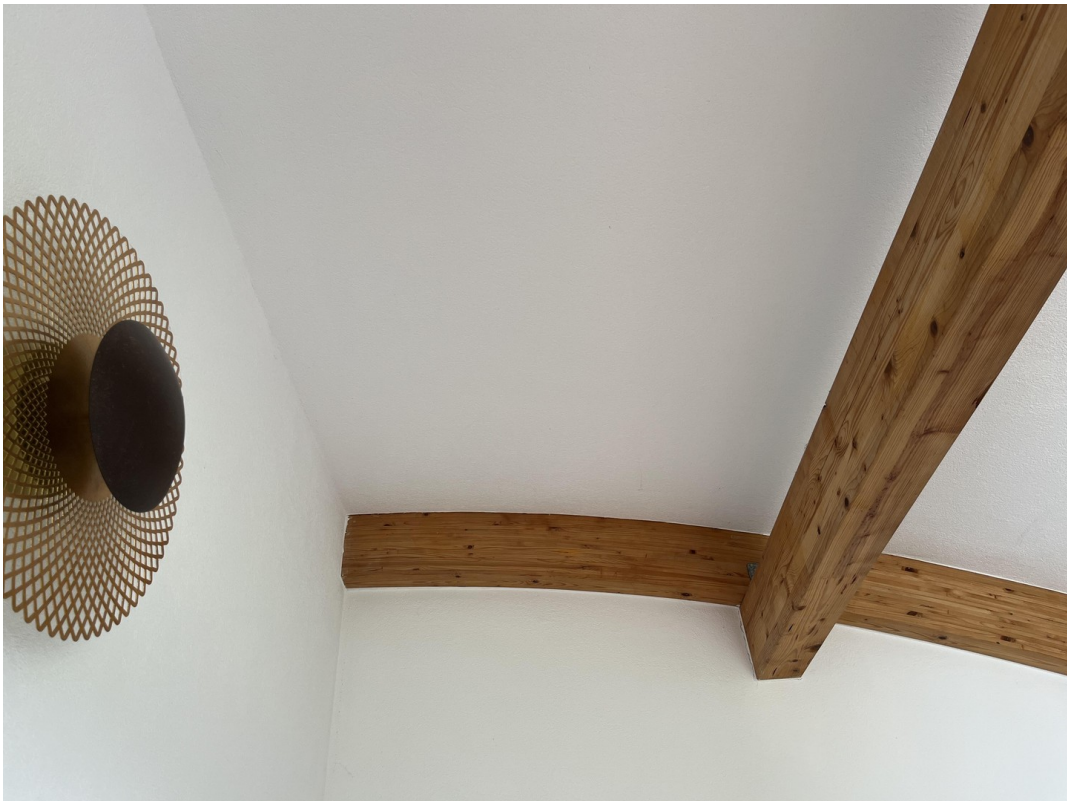
Dachbalken in DG
