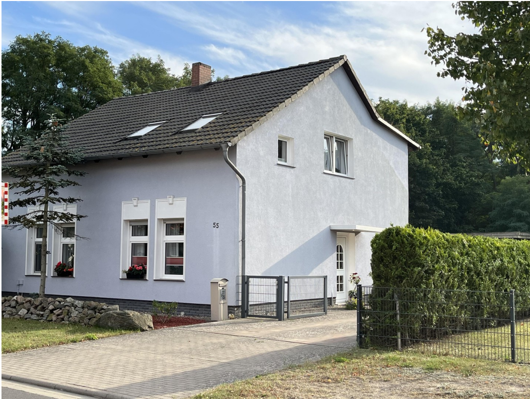
Hausansicht von der Straße aus
