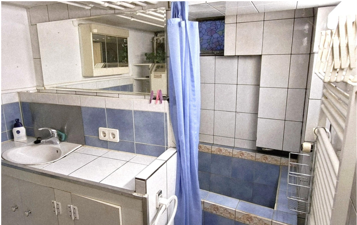
Kellerbad im Heizungsraum
