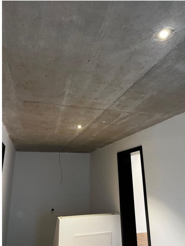
Flur OG Sichtbetondecke
