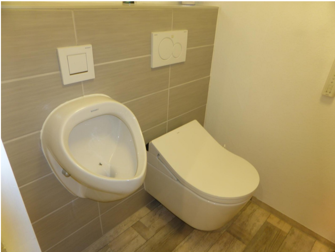
Sep. Toilette im Untergeschoss
