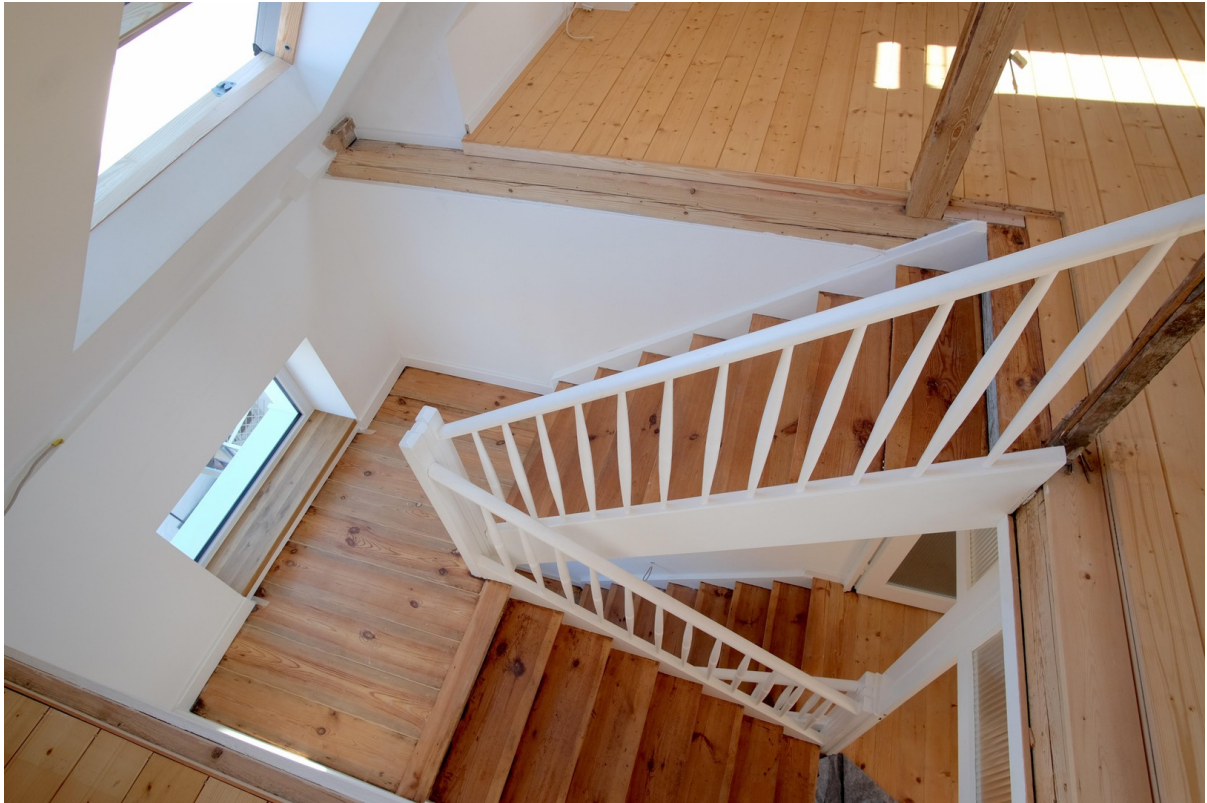
DG Treppenhaus Seite
