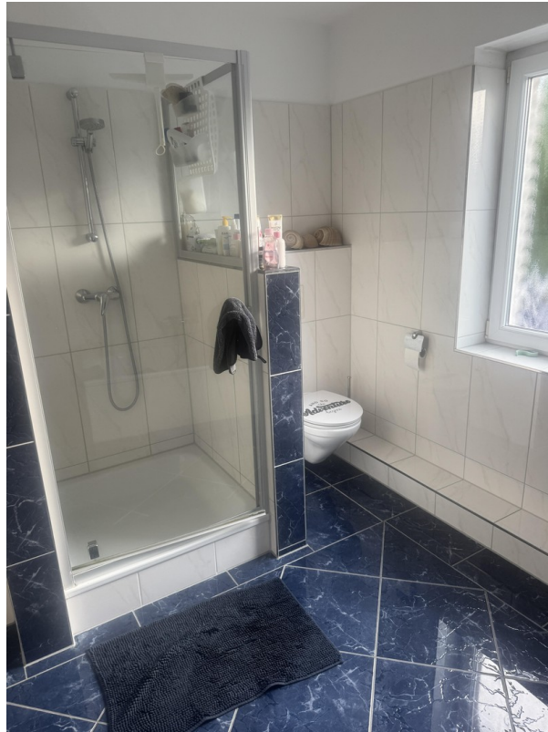
Haus 1 Badezimmer - Dusche
