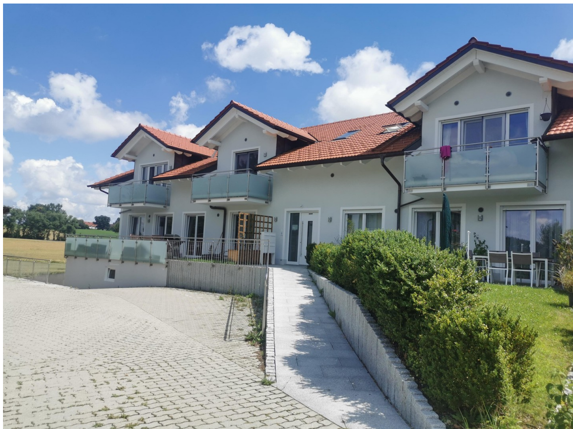
Gesamtansicht der Anlage
