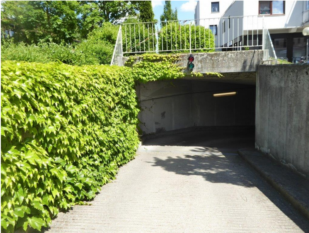
Einfahrt zur Tiefgarage
