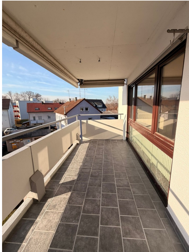
Neu modernisierter Balkon
