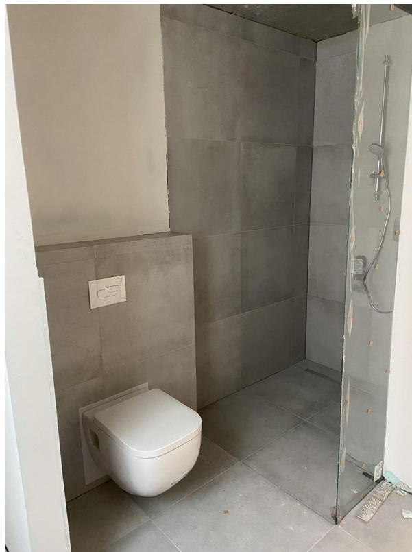
Badezimmer (während Bauphase)
