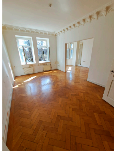
Durchbruch zwischen Wohn- und Esszimmer
