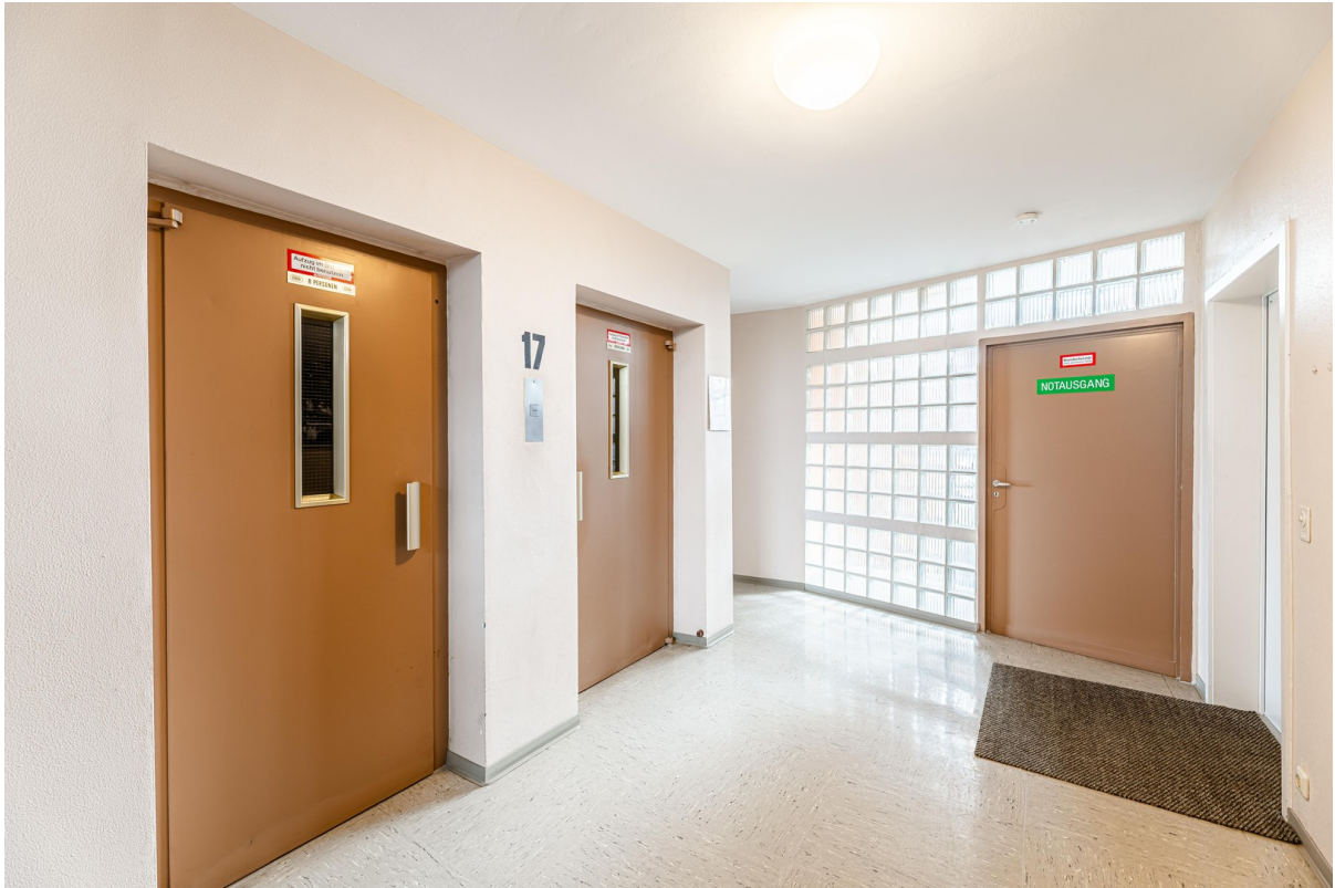
Aufzüge. Barrierefreier Zugang
