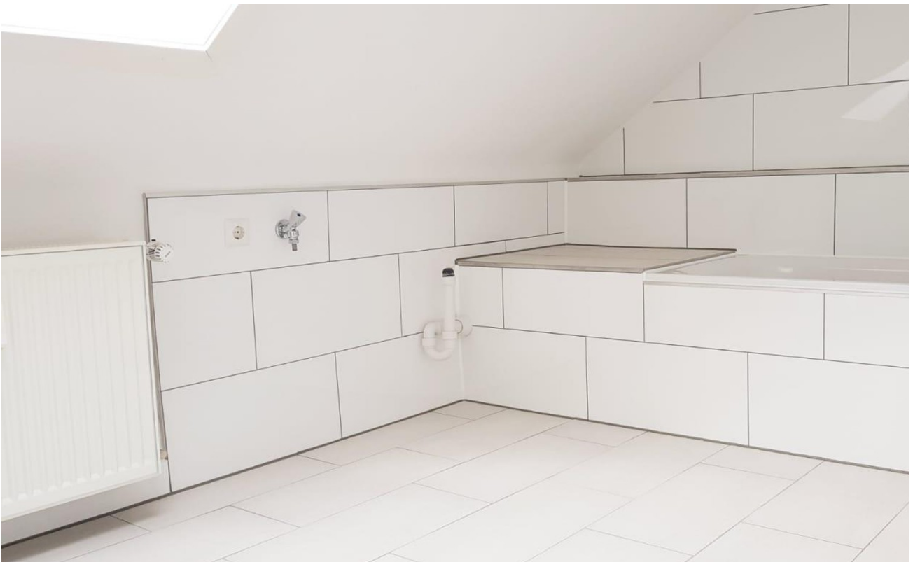
Waschmaschinenanschluss im Bad
