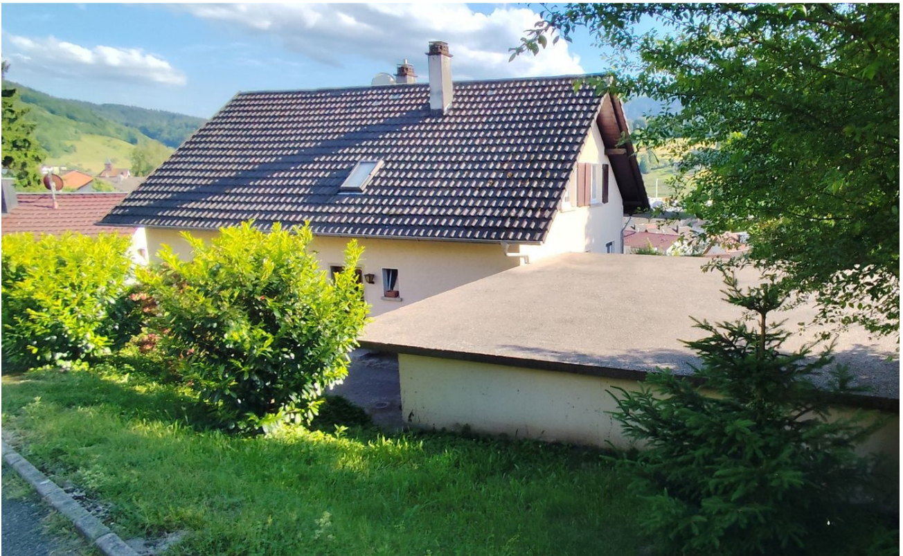
Hintere Ansicht - Doppelgarage
