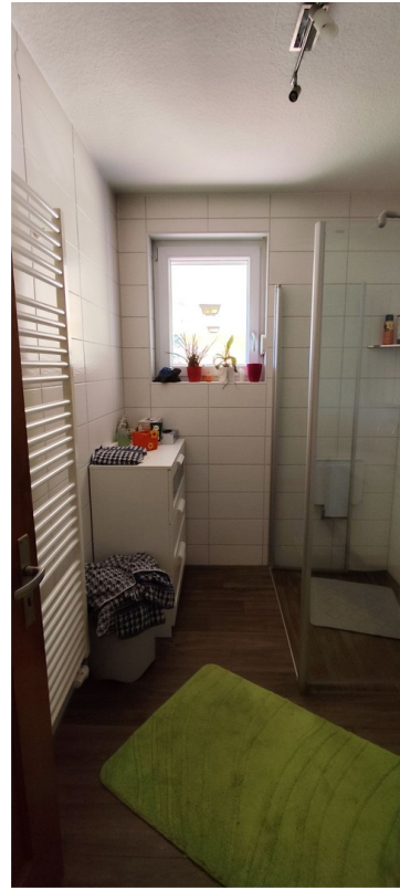
Bad 1. EG - behindertengerecht
