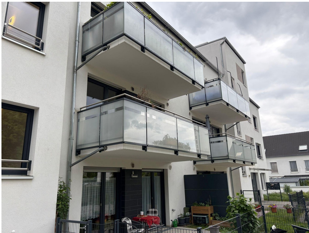
Hausansicht mit Balkon
