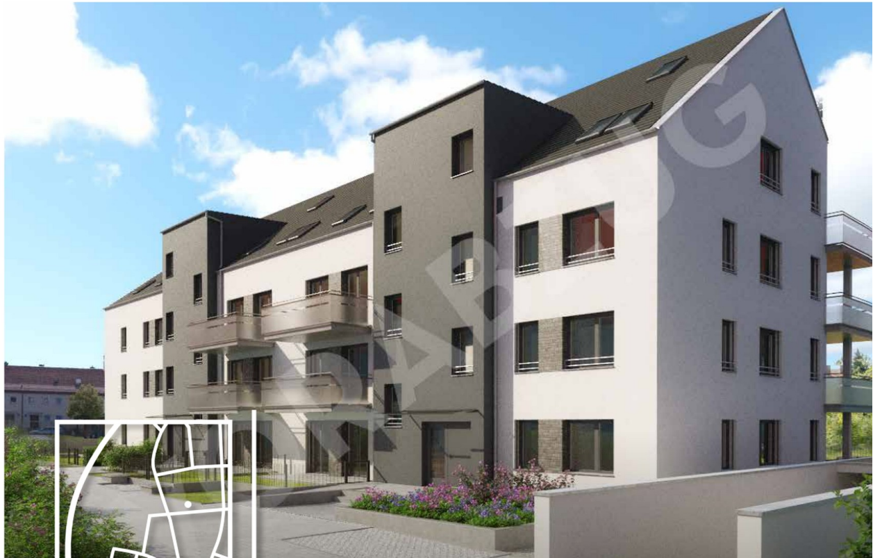
Hausansicht vom Expose
