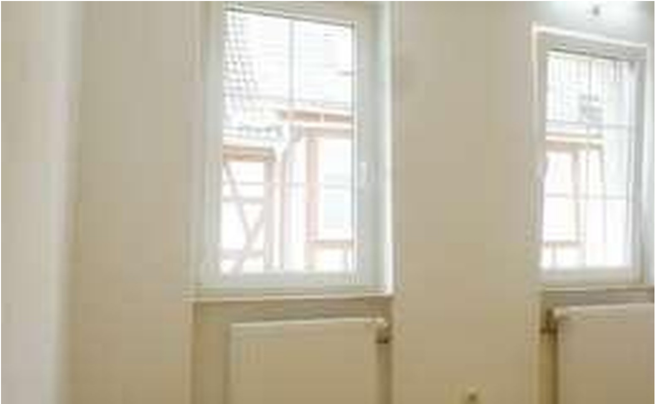
1.St- Fenster Südseite
