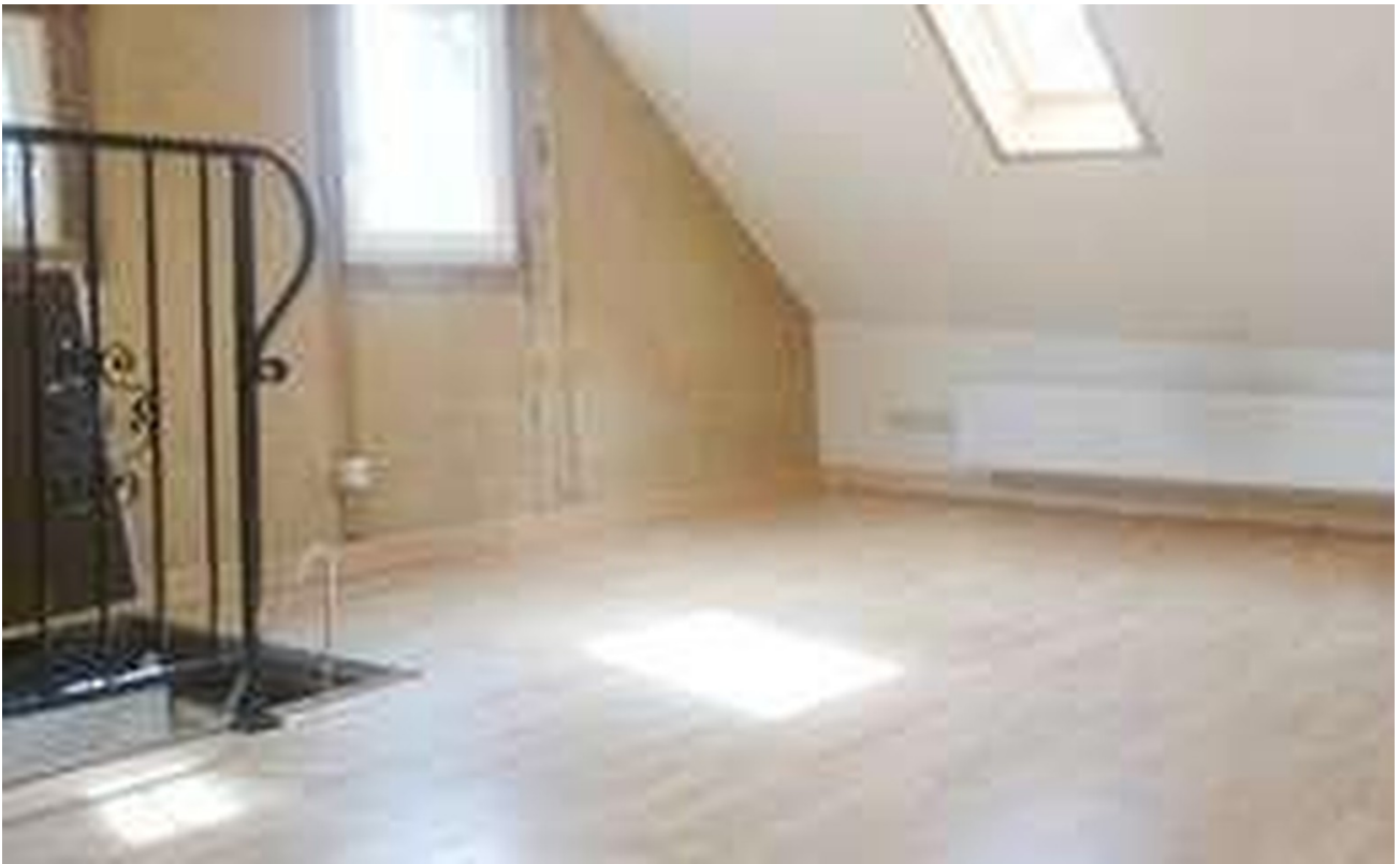
DG mit Lehm an Decke und Wand
