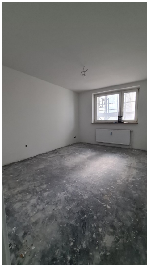
Zimmer 1 - in Renovierung
