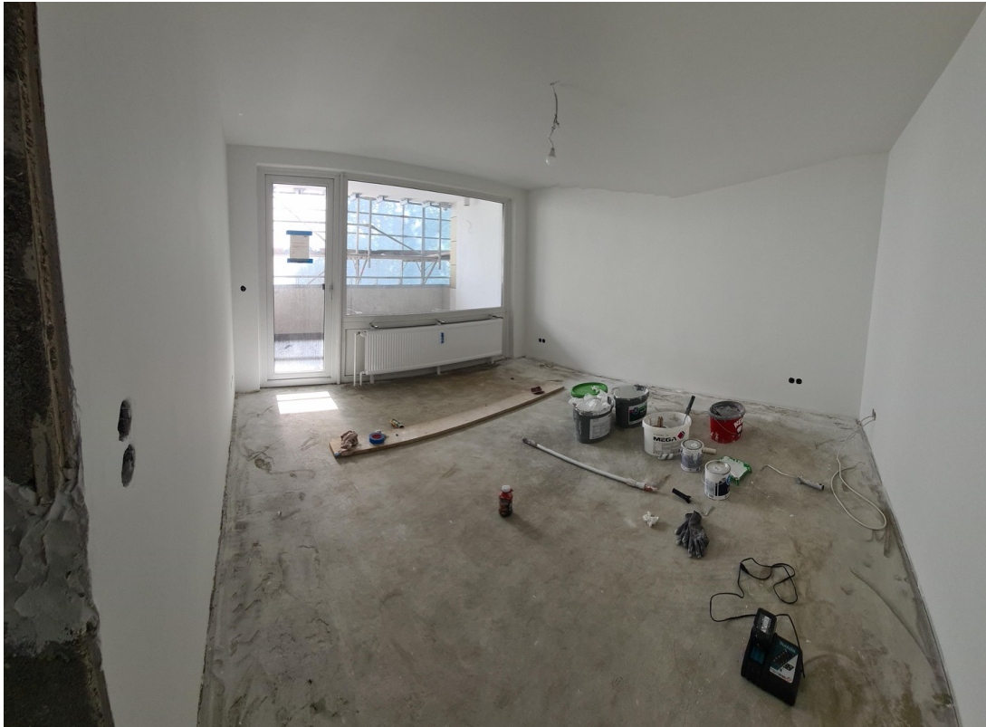
Zimmer 2 - in Renovierung
