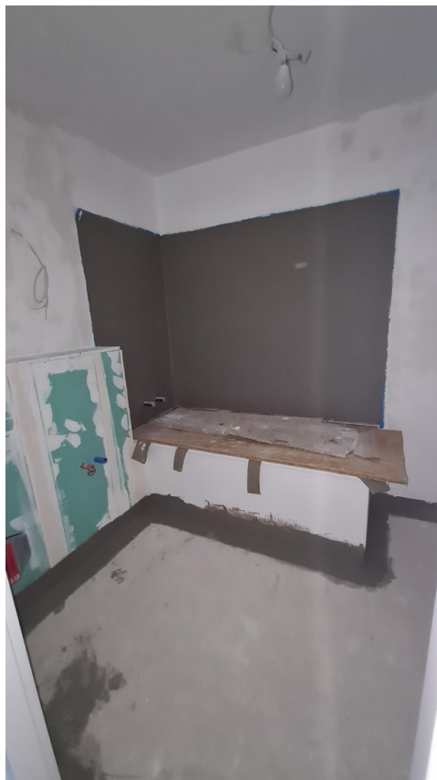
Bad in Renovierung
