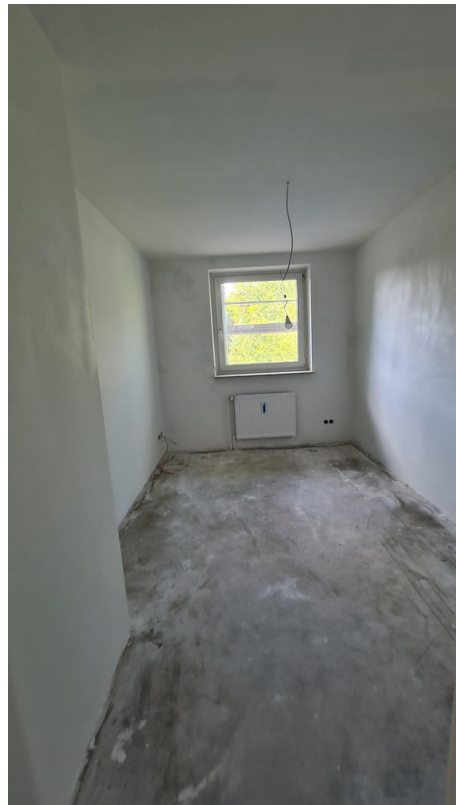
Zimmer 3 - in Renovierung
