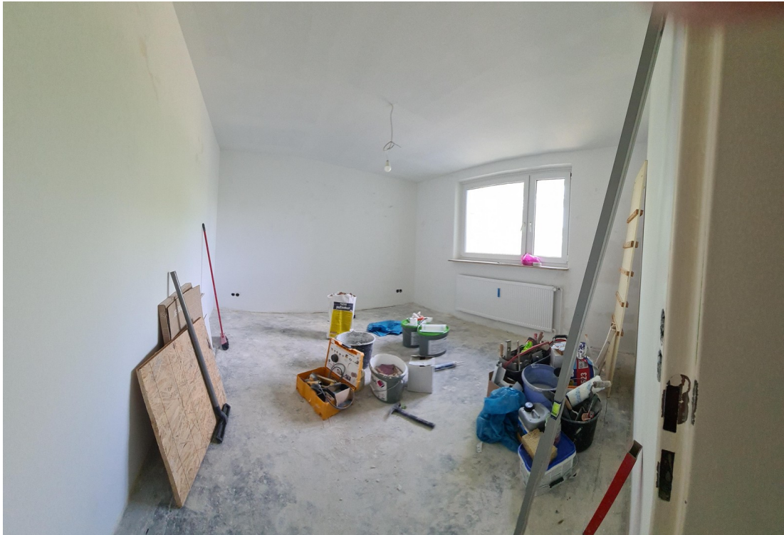
Zimmer 4 - in Renovierung
