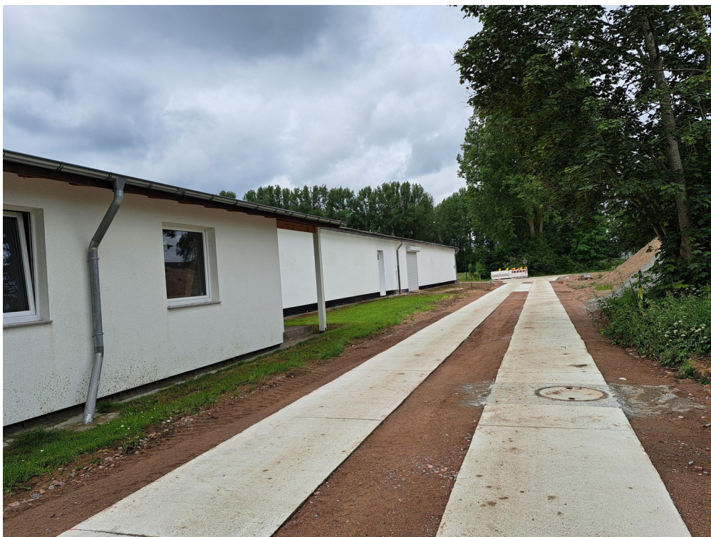
Bürotrakt, Halle, neue Straße
