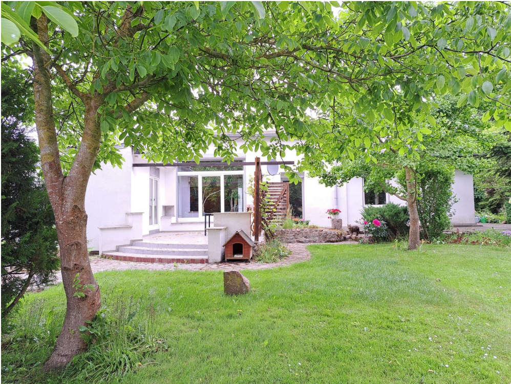
Garten mit Wohnhaus West
