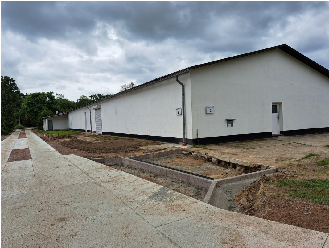
Parkstraße im Bau
