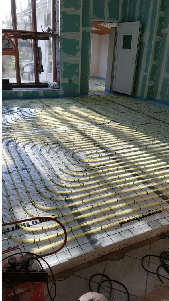
Fußbodenheizung
