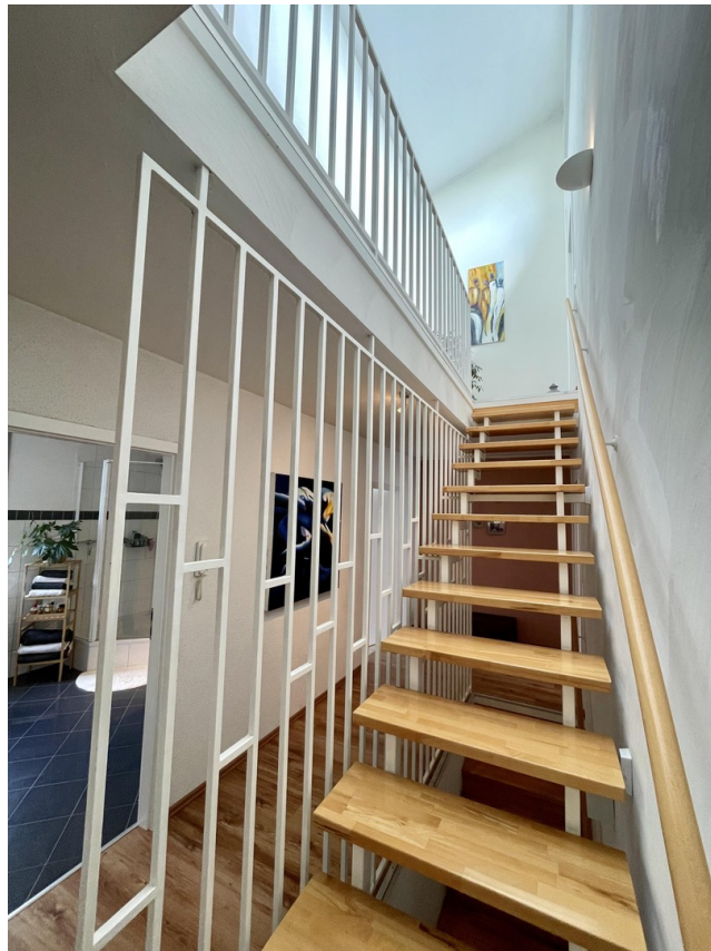
Treppenaufgang ins DG
