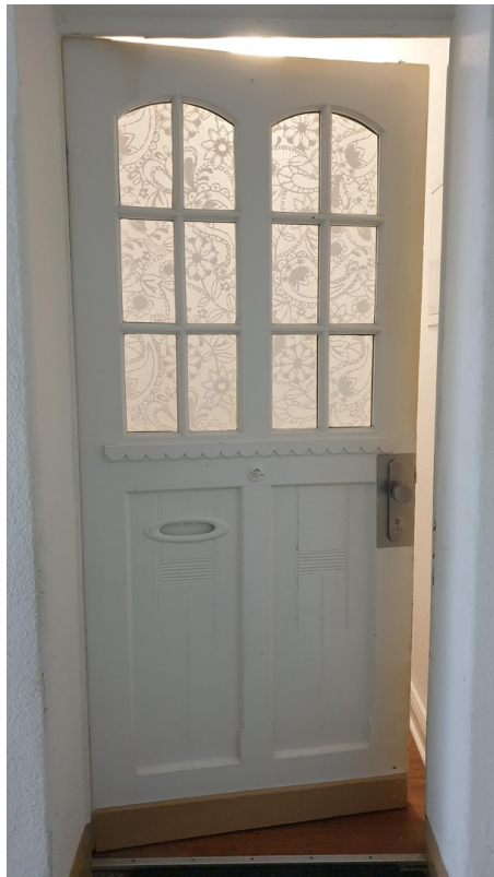
Etageneingangtür vom Hausflur
