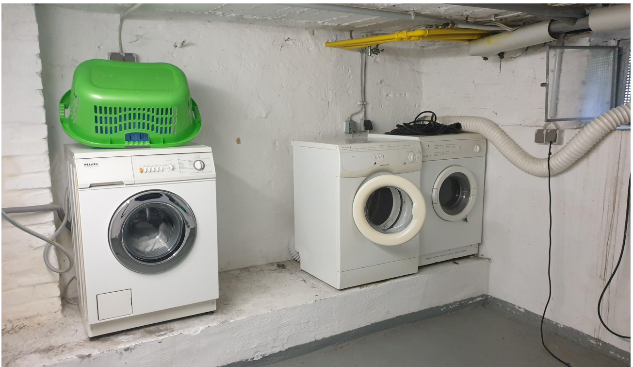
Waschraum im Keller
