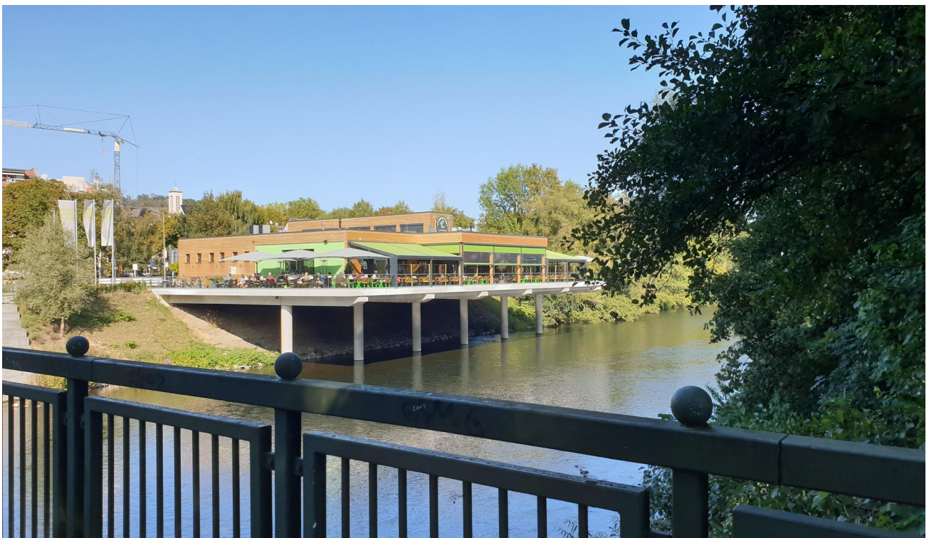
Brücke Ende Luisenstraße
