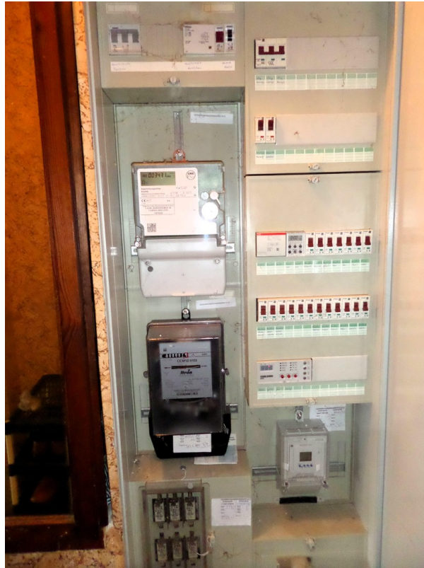
Sicherungskasten
