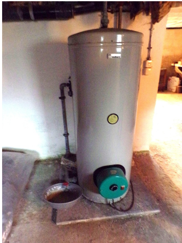
Warmwasserspeicher
