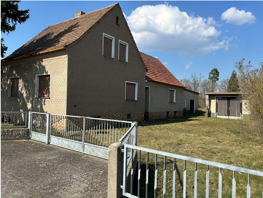
Haus Seitenansicht re.
