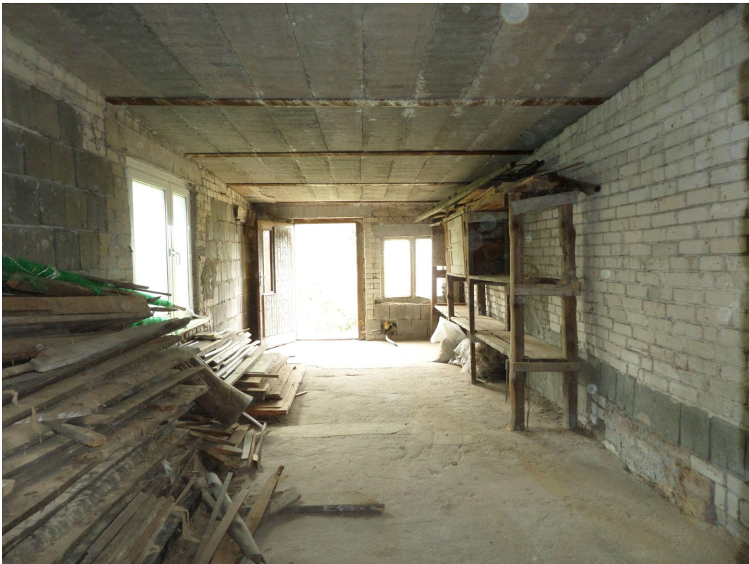
Nebengebäude Beispiel II
