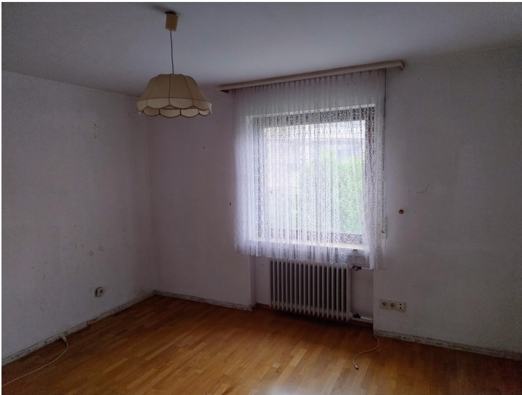
EG Kinderzimmer / Büro
