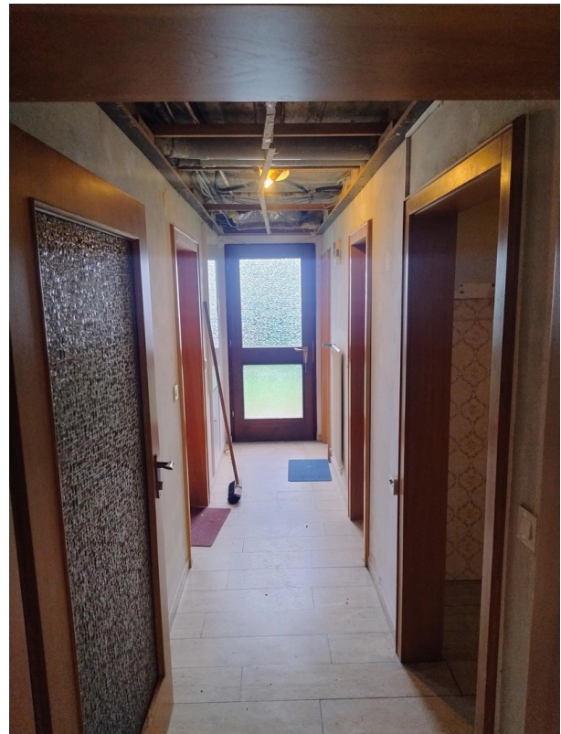
KG Flur - ohne Deckenvertäfelung
