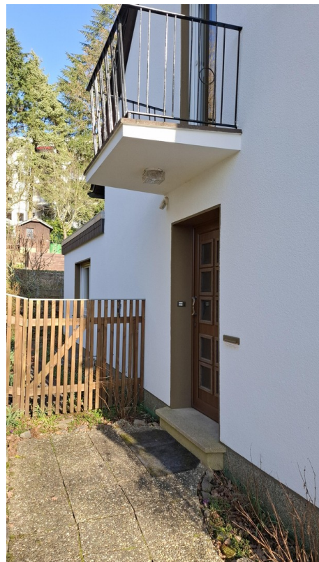
Hauseingang unter Balkon EG
